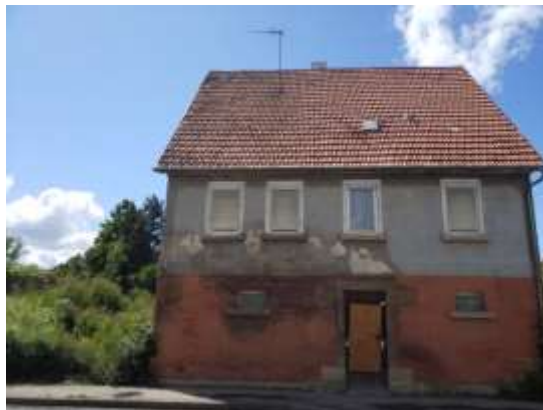
Abb. 8: Ostseite des Wohngebäudes Hindenburgstraße 47.
