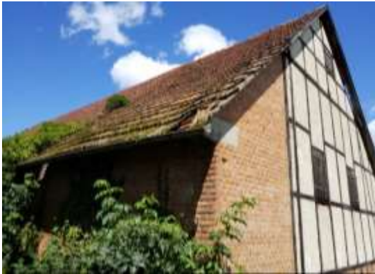
Abb. 16: Südfassade der Scheune mit Anbau.
