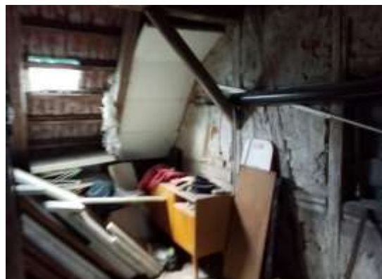
Abb. 15: Zugänglicher Dachboden (Westseite) des Wohngebäudes Hindenburgstraße 47.
