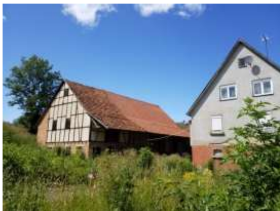
Abb. 3: Wohn- und Ökonomiegebäude Hindenburgstraße 47 von Südosten aus gesehen.
