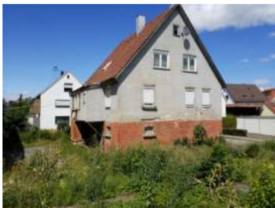
Abb. 5: Südfassade des Wohngebäudes Hindenburgstraße 47.
