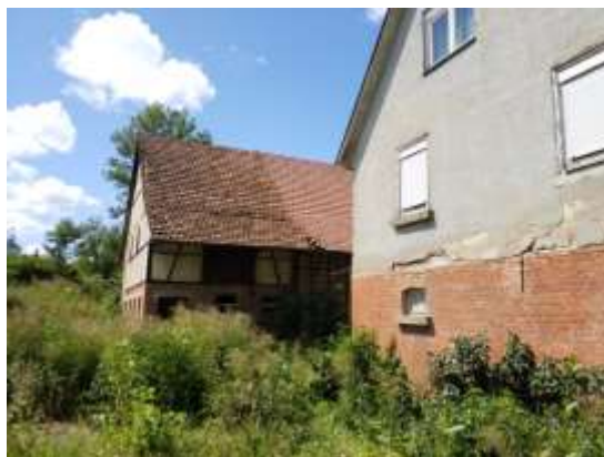
Abb. 4: Wohn- und Ökonomiegebäude Hindenburgstraße 47 von Südosten aus gesehen.
