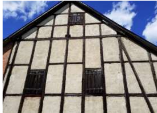
Abb. 17: Südfassade der Scheune mit Anbau.
