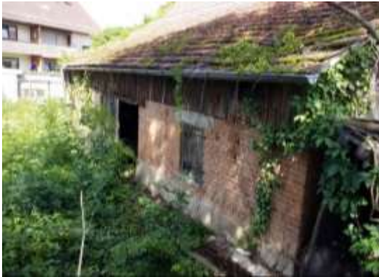
Abb. 18: Anbau Scheune (Westseite).
