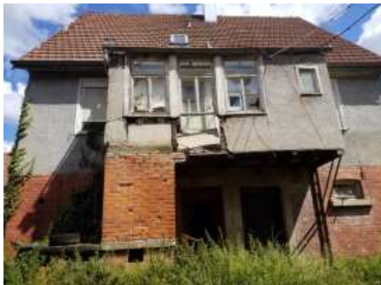
Abb. 7: Westseite des Wohngebäudes Hindenburgstraße 47.
